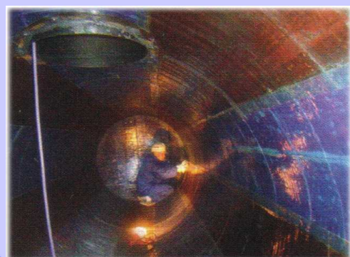
FRP貼り付け
